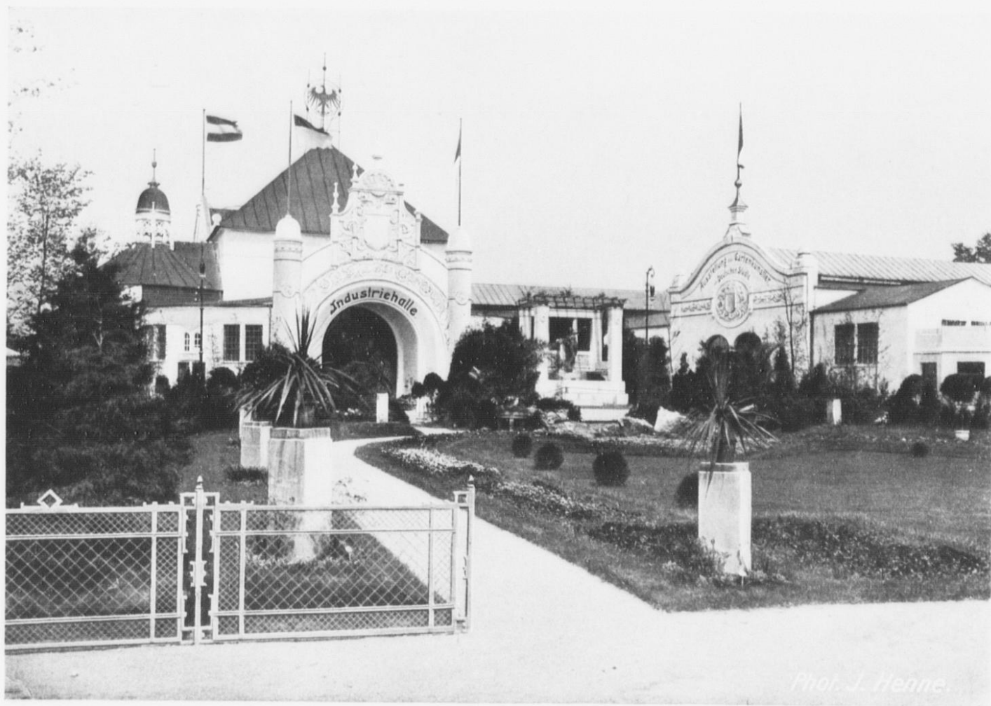
Anlage des Gartenarchitekten M. Reinhardt vorm. F. Gude und Industriehalle.
